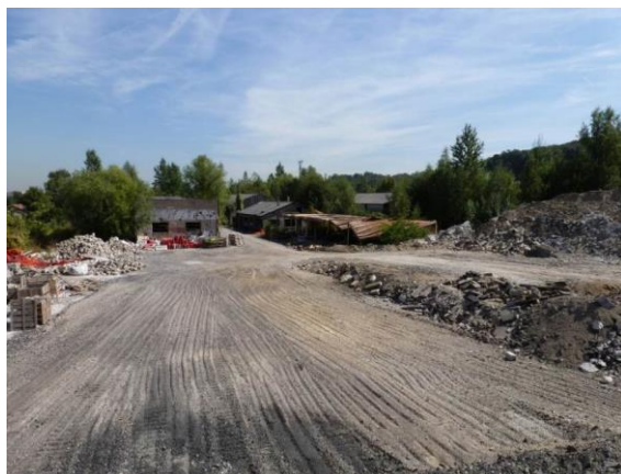
Figure 59 : Aire de stockage de matériaux sur le site de Versailles-Matelots
