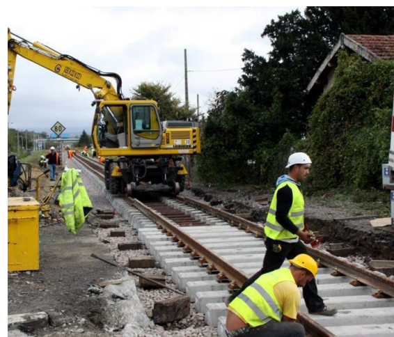
Figure 15 : Exemple de train travaux
