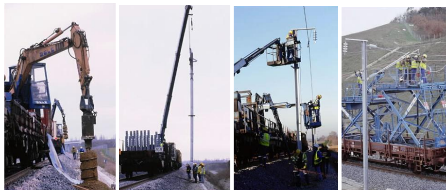
Figure 12 : Les différentes étapes de pose de la LAC
