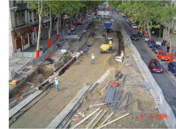
Figure 9 : Travaux de terrassement pour l'aménagement d'une ligne de tramway
