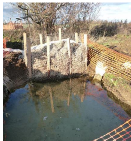
Figure 17 : Filtre à paille en sortie d'un bassin de décantation
