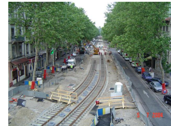
Figure 10 : Mise en place des rails
