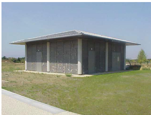
Figure 3 : Local à sous station électrique
