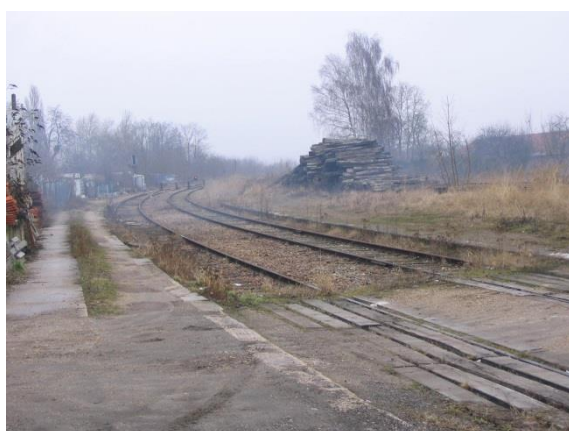
Figure 14 : Voies ferrées passant devant l'ancienne gare de Saint-Cyr GC
