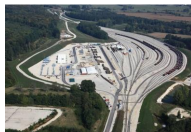
Figure 4 : Base travaux sur la ligne LGV Est
