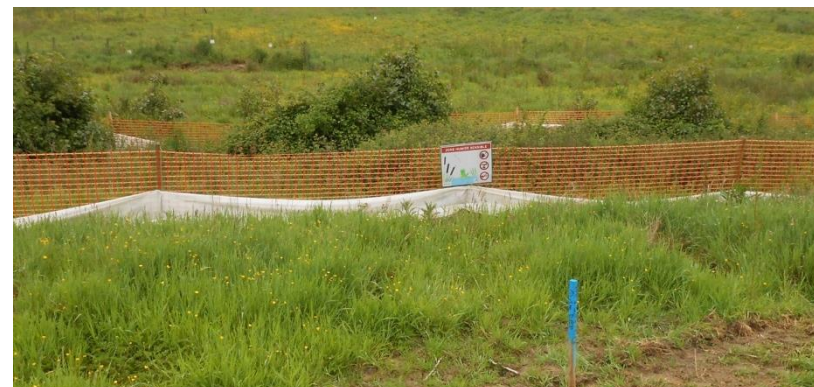
Figure 27 : Exemple de grillage provisoire de chantier
