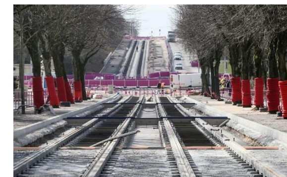
Figure 11 : Travaux de construction de la plateforme du Tramway – Dijon
