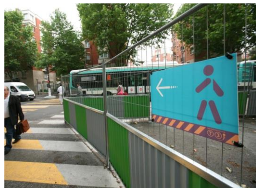
Figure 33 : Signalisation provisoire en bordure de chantier pour guider les piétons
