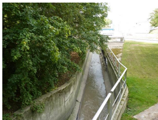
Figure 42 : Ruisseau de Gally entre la station d'épuration et le tracé
