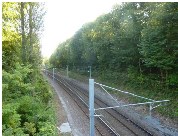
Figure 53 : Voies aménagées au Sud de la gare de Saint-Nom-la-Bretèche
