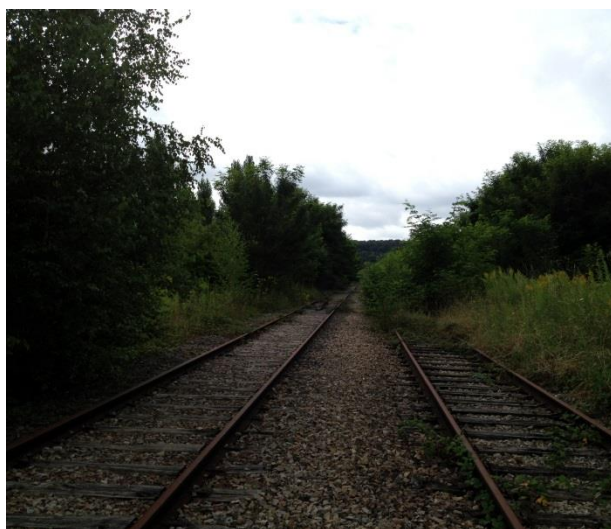
Figure 55 : Voie ferrée existante désaffectée au Sud de la ferme de Gally
