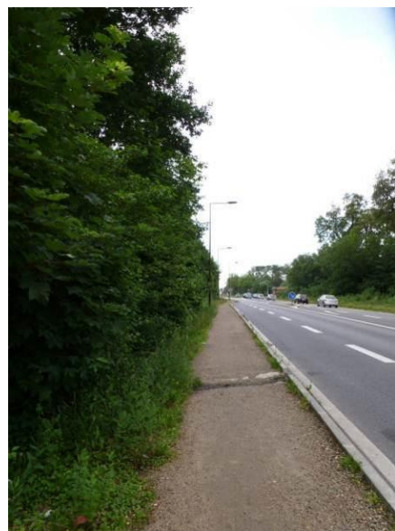
Figure 48 : Lisière le long de la RN 184
