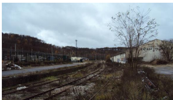
Figure 66 : Vue sur la plateforme de la Grande Ceinture à Versailles-Matelots
